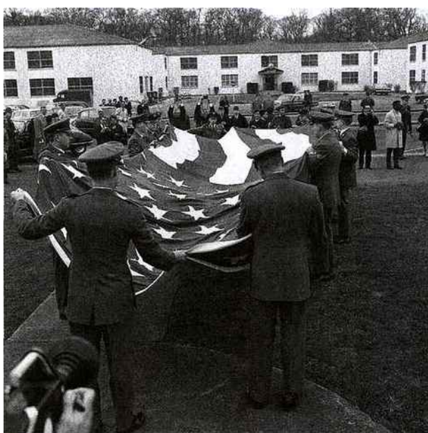
Rupture. Le QG de l'Otan, à Saint-Germain-en-Laye, se prépare à déménager pour Mons, en Belgique.
